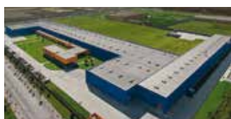
Hörmann Tianjin, Cina
